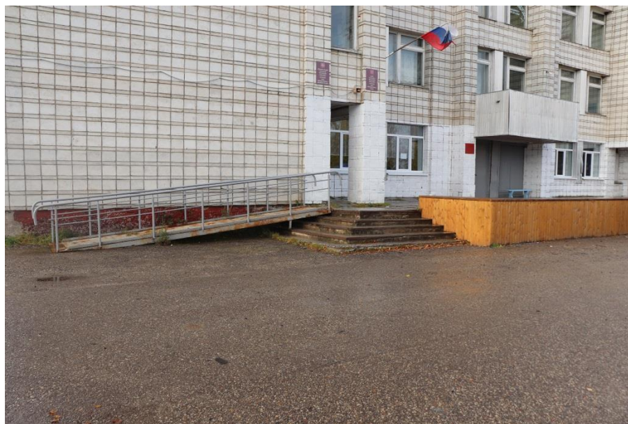
Здание оборудовано пандусом
